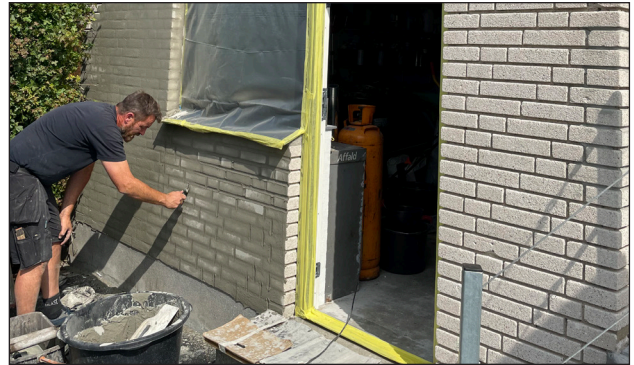
Skalflex Multi-Rep 2080 påføres som udfyldningslag, skures godt ind, og fugerne markeres.
